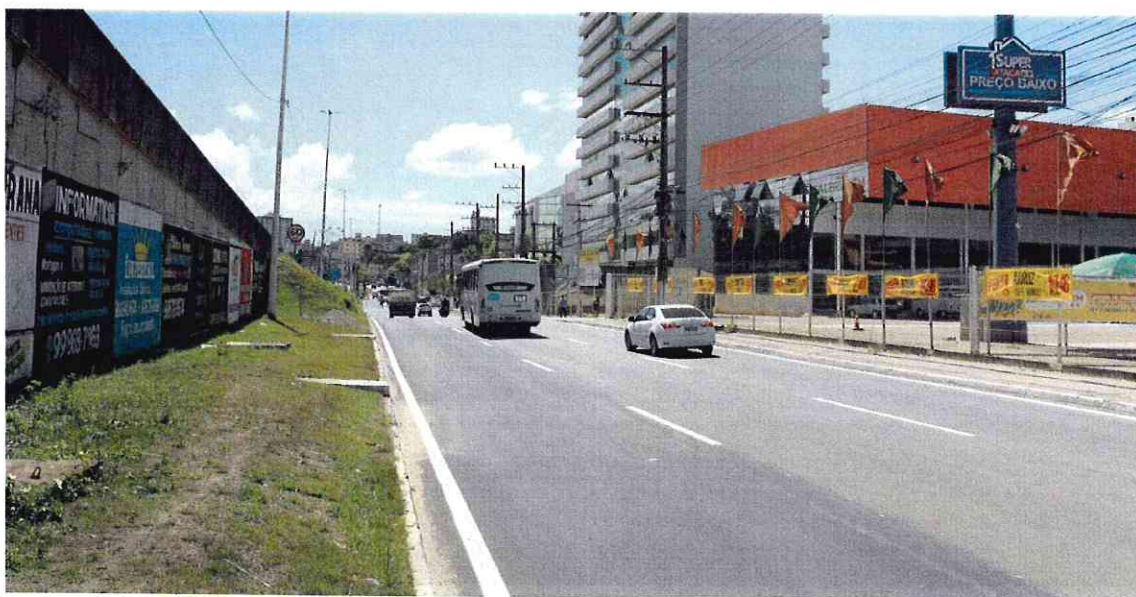
Figura 6 – Terceira Faixa concluída em 2023, no trecho da Avenida Mário Gurgel em frente ao Shopping Moxuara.
