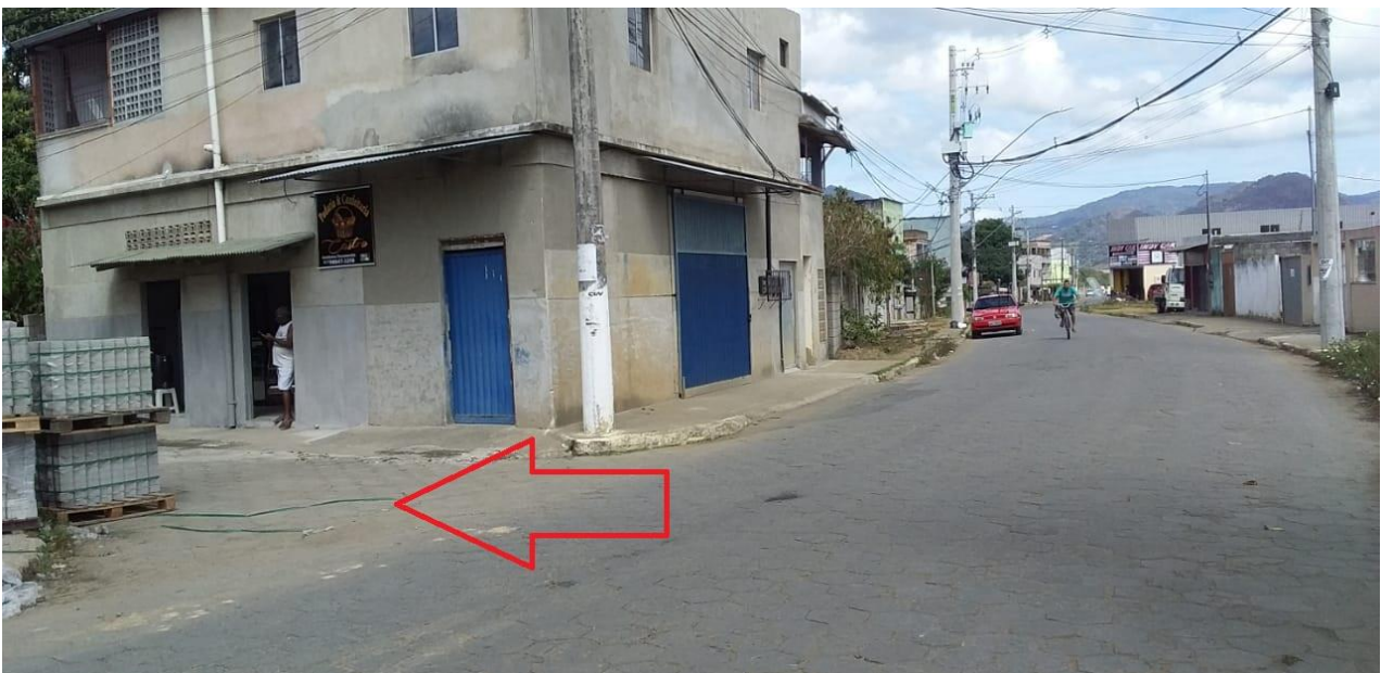
Foto 02. Vista lateral da atual rua “sem nome”.
